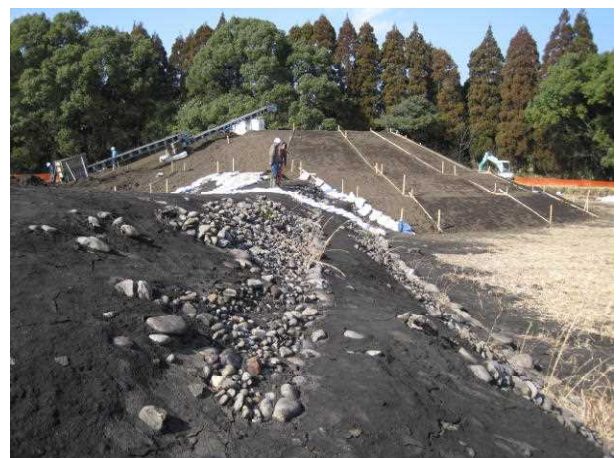
再整備中の100号墳
