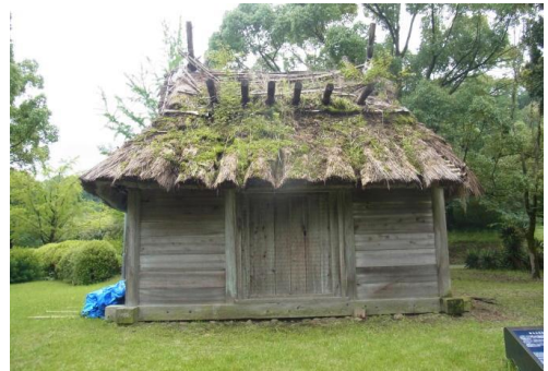
【改修前の「古代復元住居」】 平成 27 年 4 月
