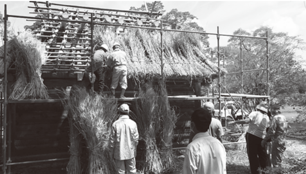
茅葺き屋根の葺き替え作業
