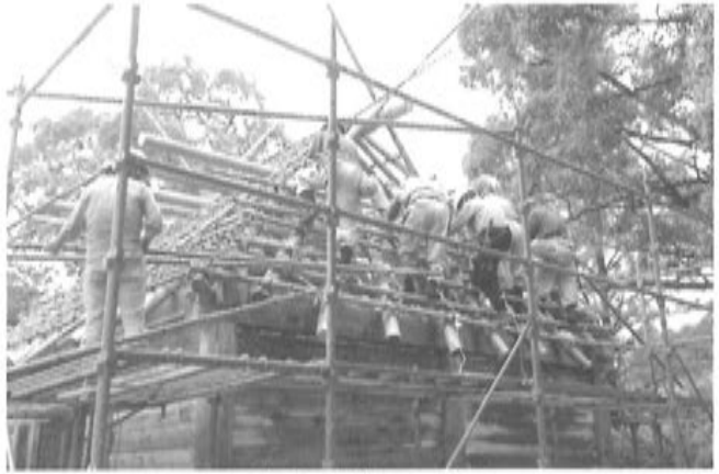
写真22 骨組み工程③
