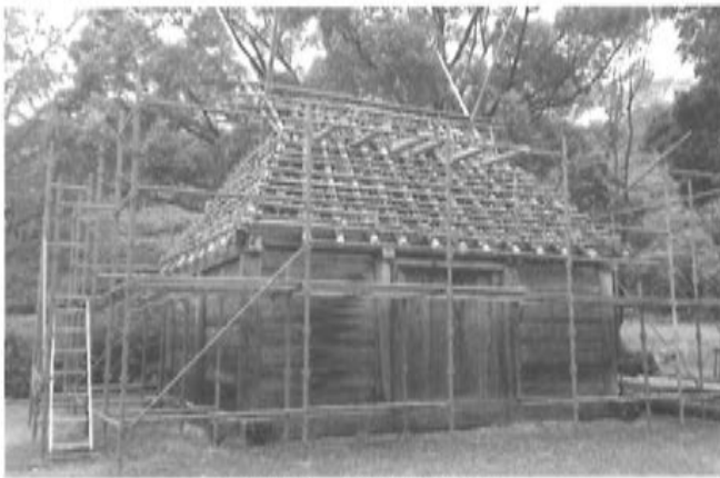
写真23 骨組みの完成
