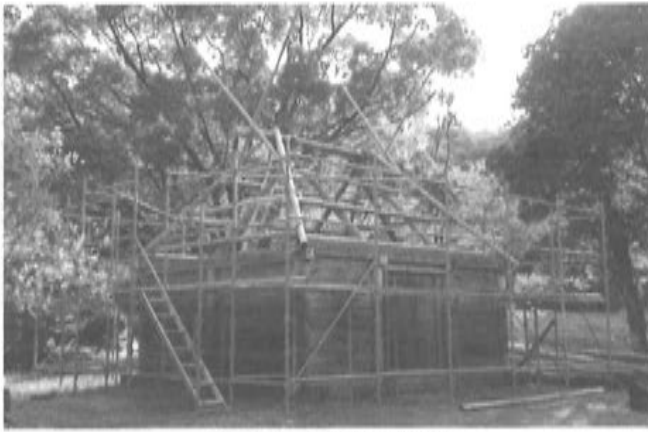
写真19 骨組み工程①
