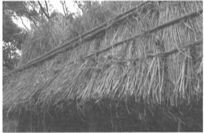
写真6 縛り付けた茅を竹で押さえる
