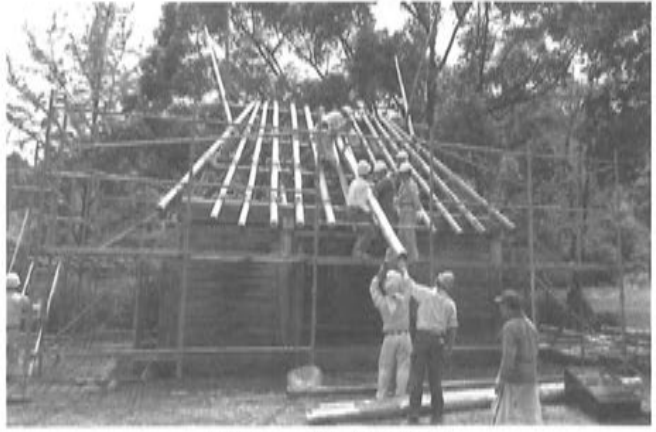
写真20 骨組み工程②
