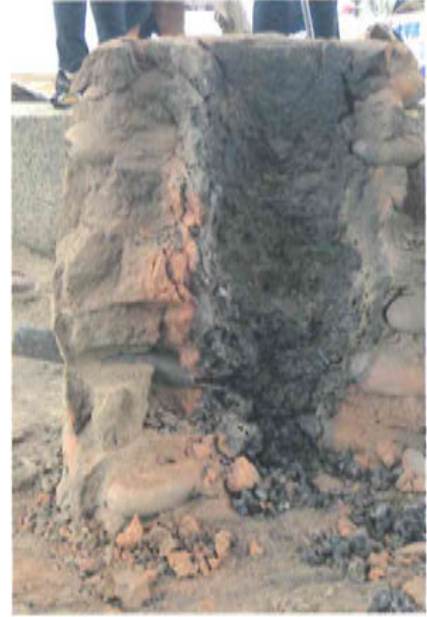
写真7 炉解体時の炉内 (テスト実験)
