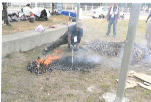
写真2 炉底部の焼き締め作業（テスト実験）
