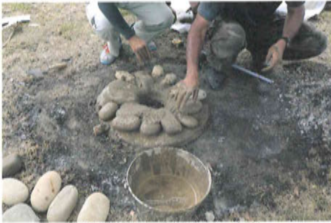
写真3 築炉作業1 (テスト実験)
