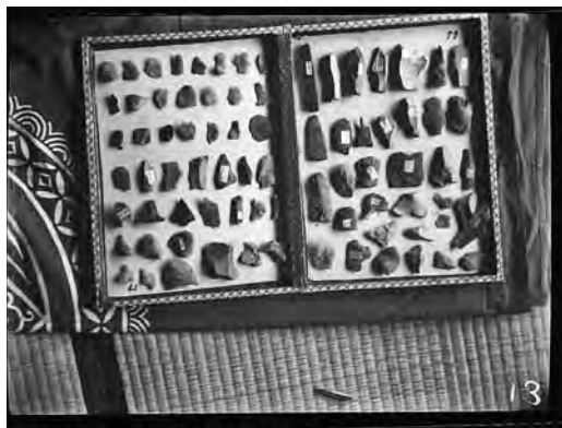
写真8 剥片等（写真所蔵：諏訪市博物館） ※写真3～8は全て写真のみで、実物は戦災で失われている。
